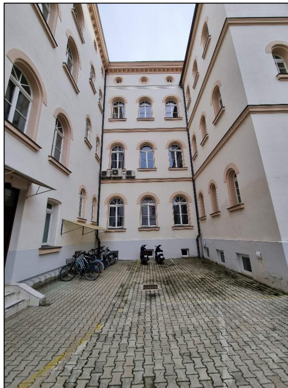
Slika 2: Območje predvidenega dvigala (Foto: 13.1.2023)
